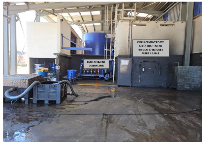
Bâtiment annexe dédié aux cuves de stockage et au sein duquel est prévue la station de prétraitement
