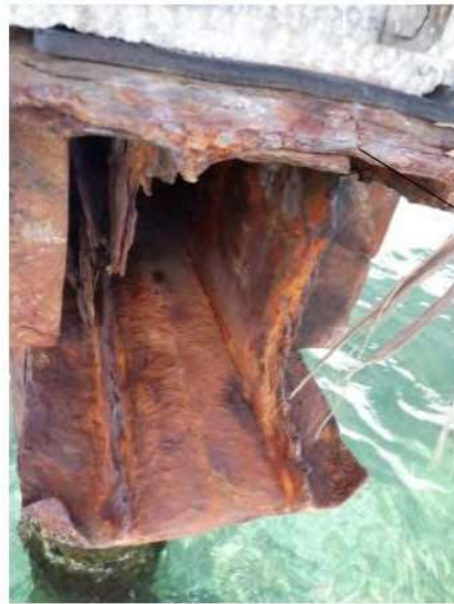
Figure 2 : Illustration de la corrosion des poutres acier (source APAVE 2023)
