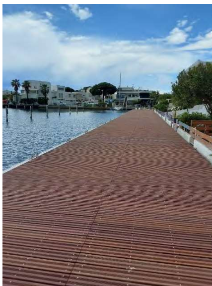
Figure 9 : exemple d'un ponton fixe avec platelage en bois exotique Massaranduba
