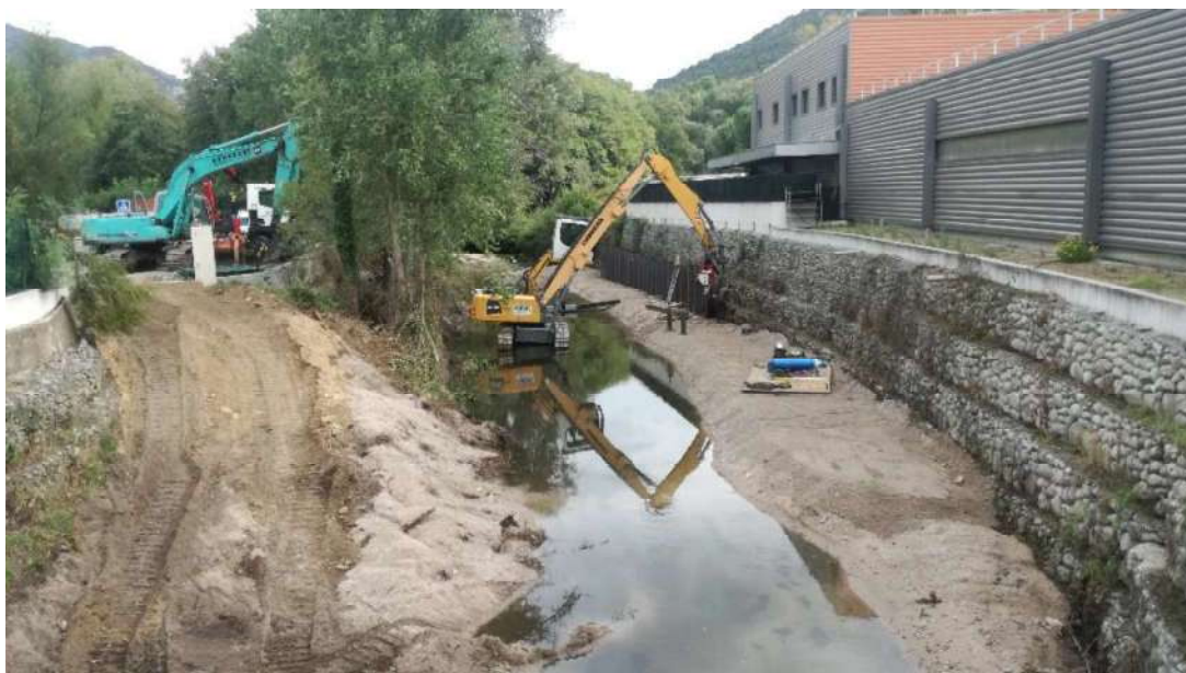
Fig. 2. Travaux (mise en place de palplanches) sur le Sagone
