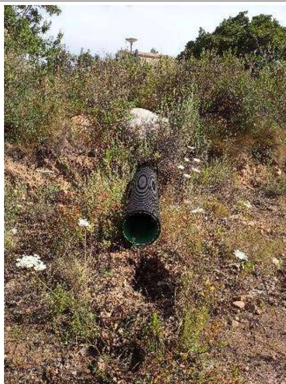
Photo 2 -Canalisation d'arrivée Ø300 PVC dans BI1
