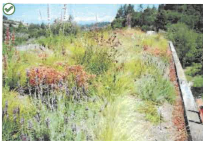
Toiture plantée - substrat 15 à 25 cm
