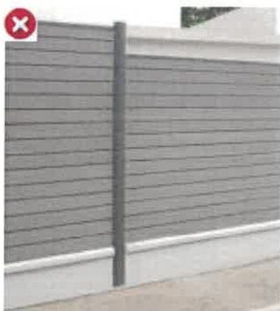
Panneaux soudés sur mur maçonné
