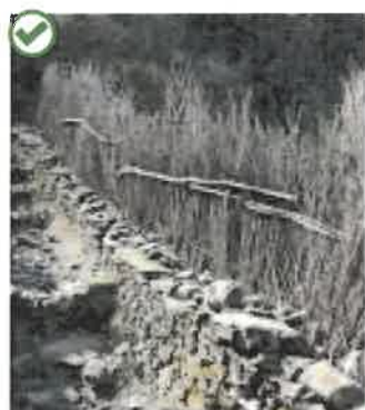
Mur en pierre sèche surmonté de fagots de bruyère
