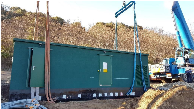
Figure 4 : Photographie de l'installation d'un local technique
