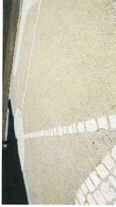
Voirie perméable Sol en tuf tabillisé Lignes de pierre de blocage
