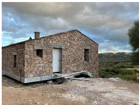
Maison en construction sur la partie habitation du projet d'ensemble: tuiles canales anciennes, murs parés de moellons de granite à joints secs, linteaux en poutres anciennes
