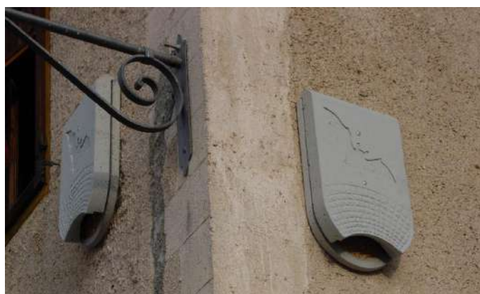
Figure 17. Gîtes à Chiroptères pouvant être intégrés sur les murs des villas ou du local de jardin.
