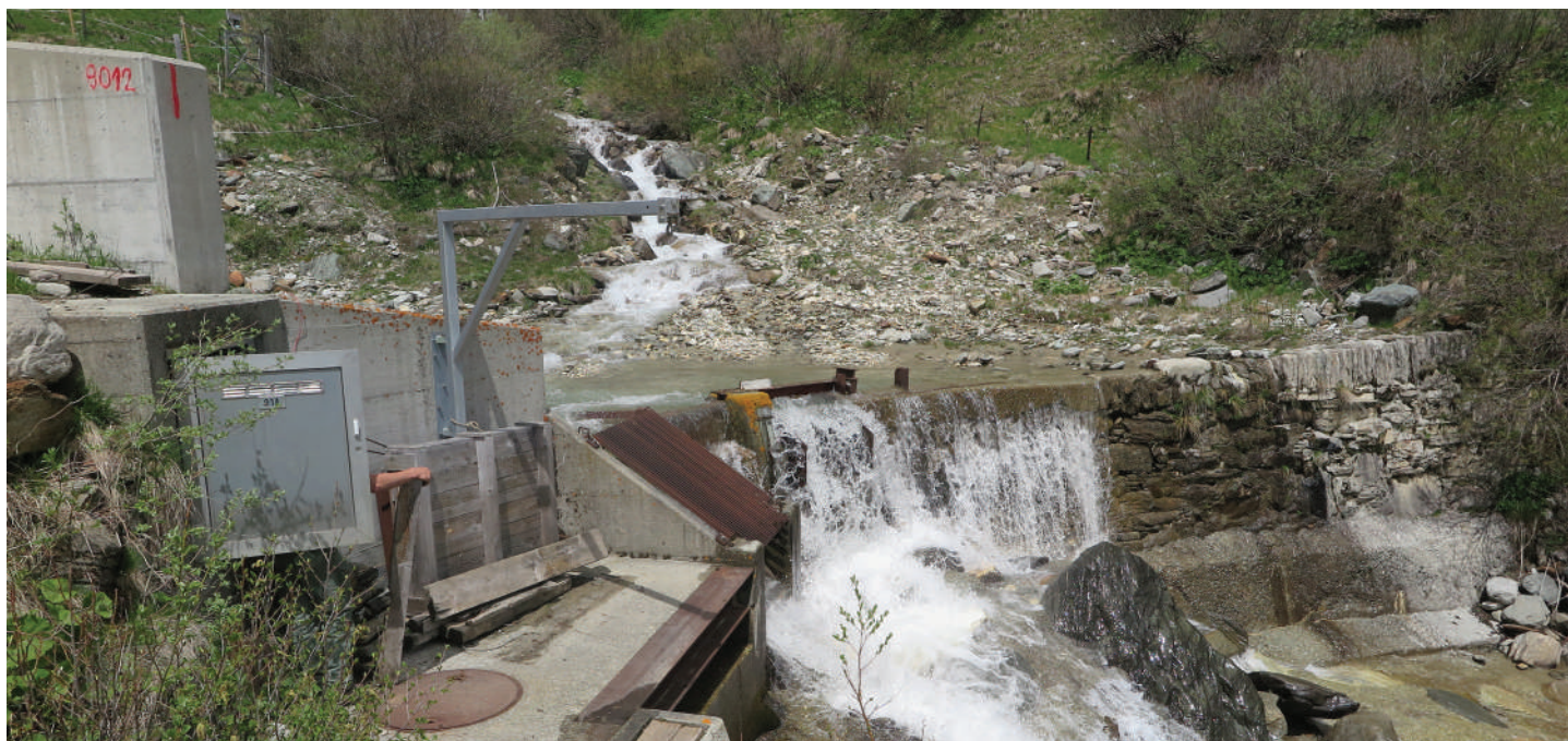
La première grille Coanda en Suisse a été installée en 1998 sur le Rappierbach dans la commune de Hinterrhein (GR). L'espace entre les barres de la grille d'un mètre de large s'élève à 1 mm et la capacité spécifique de débit à 140 l/s. Sur l'image, la grille Coanda est cachée sous la grille de protection. La grille sert à maintenir les grosses pierres à distance de la grille Coanda en cas de crue. Photo : HTW Chur
