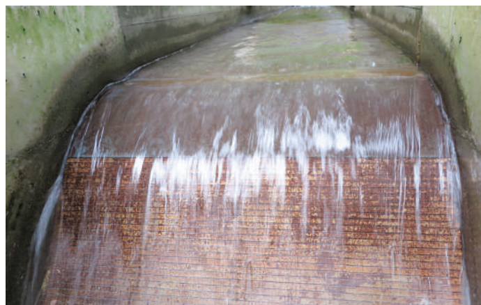
Gros plan d'une grille Coanda : Les barres métalliques horizontales agissent comme des lames de rasoir qui coupent l'eau par couches. Photo : HTW Chur
