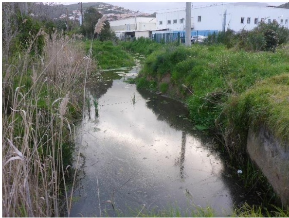
Fossé partie sud
