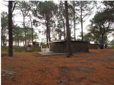
> Bungalows et leurs dalles béton abandonnées dans la pinède à démonter et évacuer
