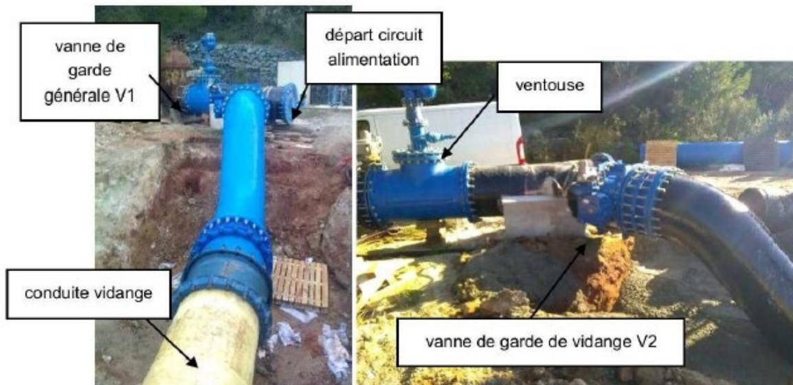
**Figure 19. Vue de la pièce en Y de séparation du circuit de vidange et d'alimentation (extrait VTA 2020)**
