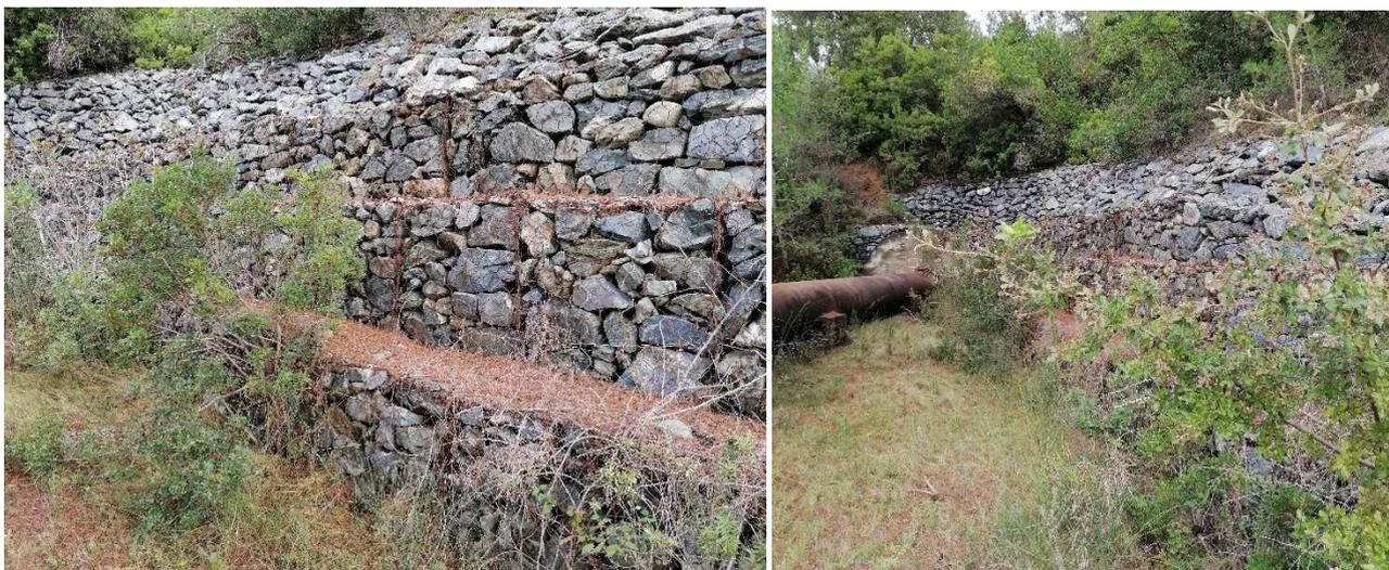
**Figure 17. Vue de l'ouvrage en gabions à l'entrée aval de la galerie**
