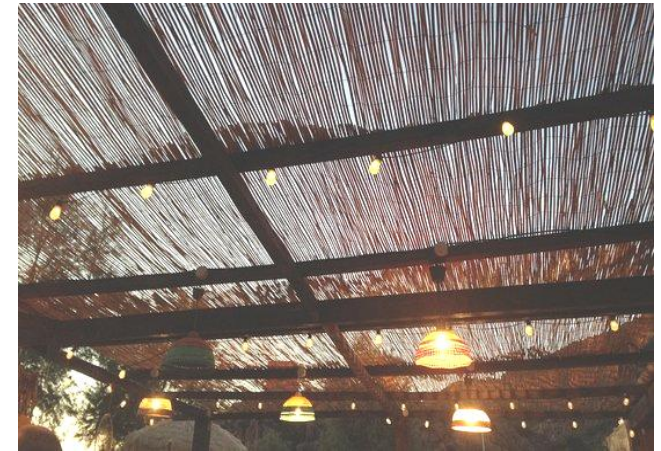
Auvent en bois et canisses. Eclairage de faible densité, orienté vers le sol
