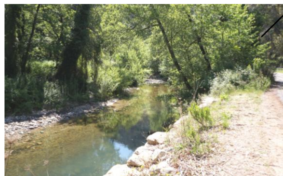
La berge enrochée à restaurer
