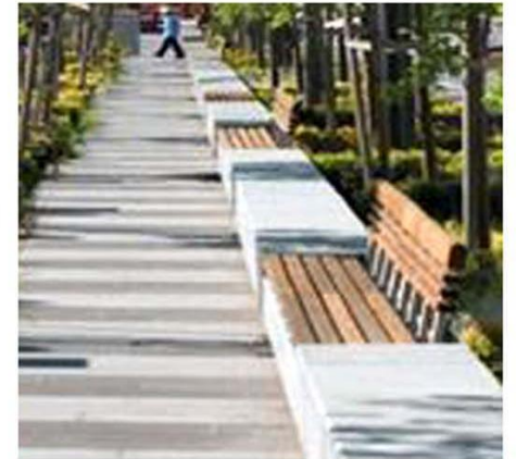
Bancs en bois encastrés le long du muret
