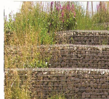
Gabionnage en restanques végétalisées
