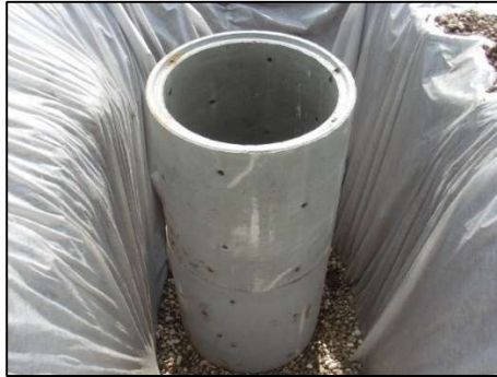
Photo 3 : Exemple de puits d'infiltration (buse béton perforée)
