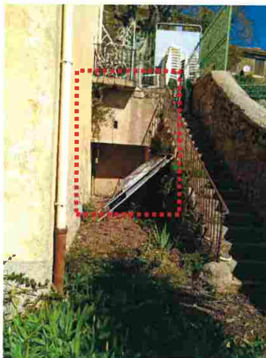
Figure 2 : annexe située en façade est du bâtiment
