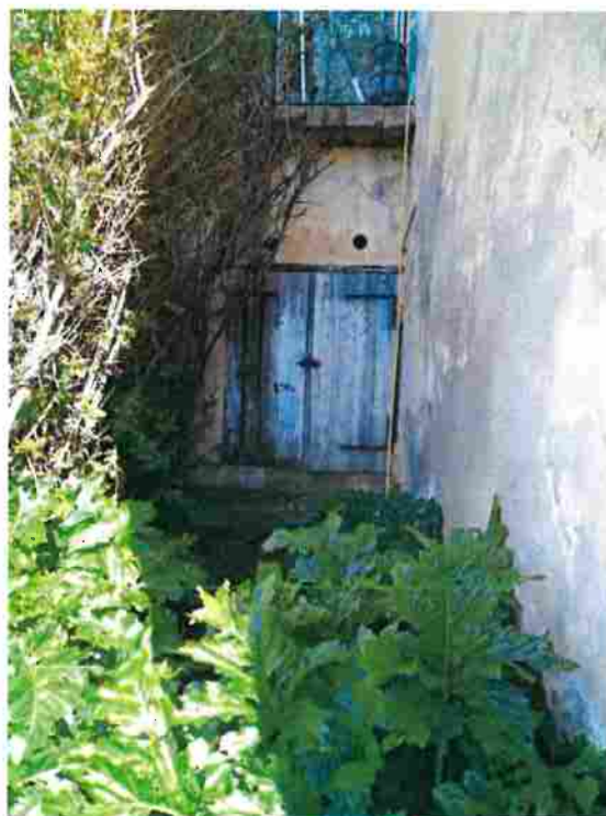
Figure 3 : Annexe située en façade ouest du bâtiment
