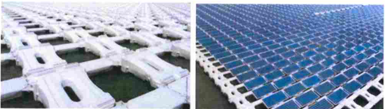
Figure 6 : Assemblage des flotteurs et mise en place des panneaux solaires
