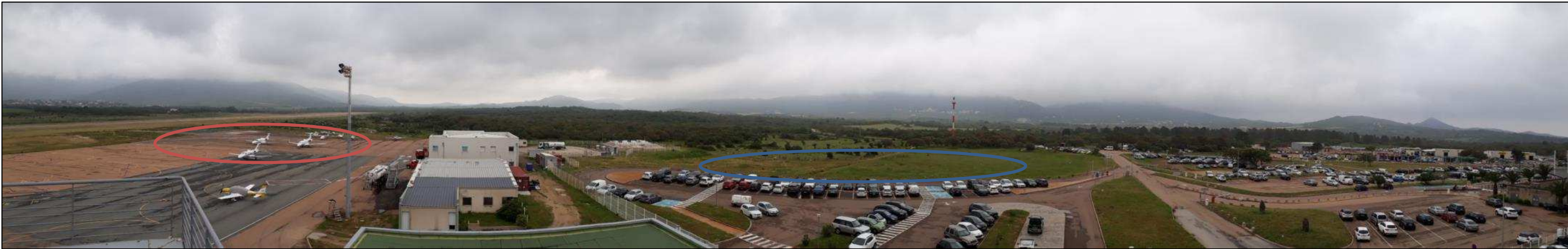
Photographie n°3 : vue panoramique sur la zone d'implantation du projet (11/05/2018)
