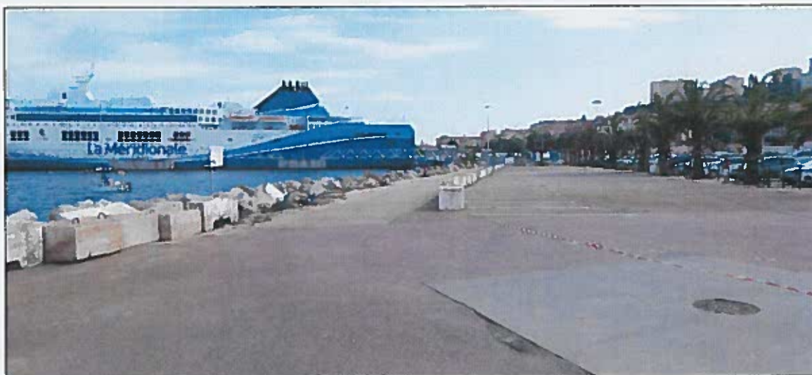
6 - Vue de la voie d'accès et la zone de parking non utilisée (1 er juin 2017)
