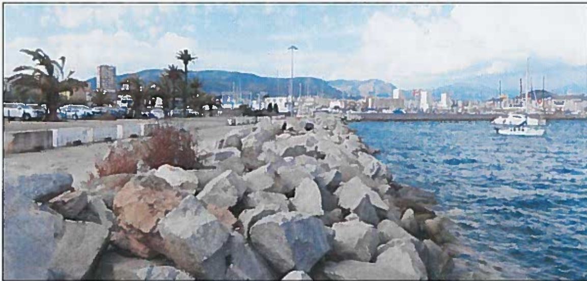
3 - Vue de la protection en enrochements (1er juin 2017)
