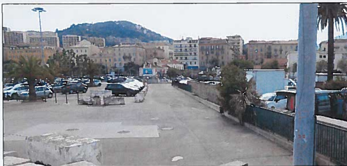
8 - Vue de la voie d'accès Nord (1 er juin 2017)
