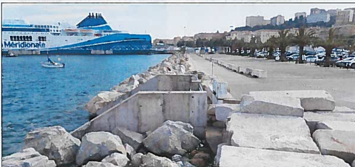
5 - Vue de l'exutoire d'eaux pluviales (1er juin 2017)
