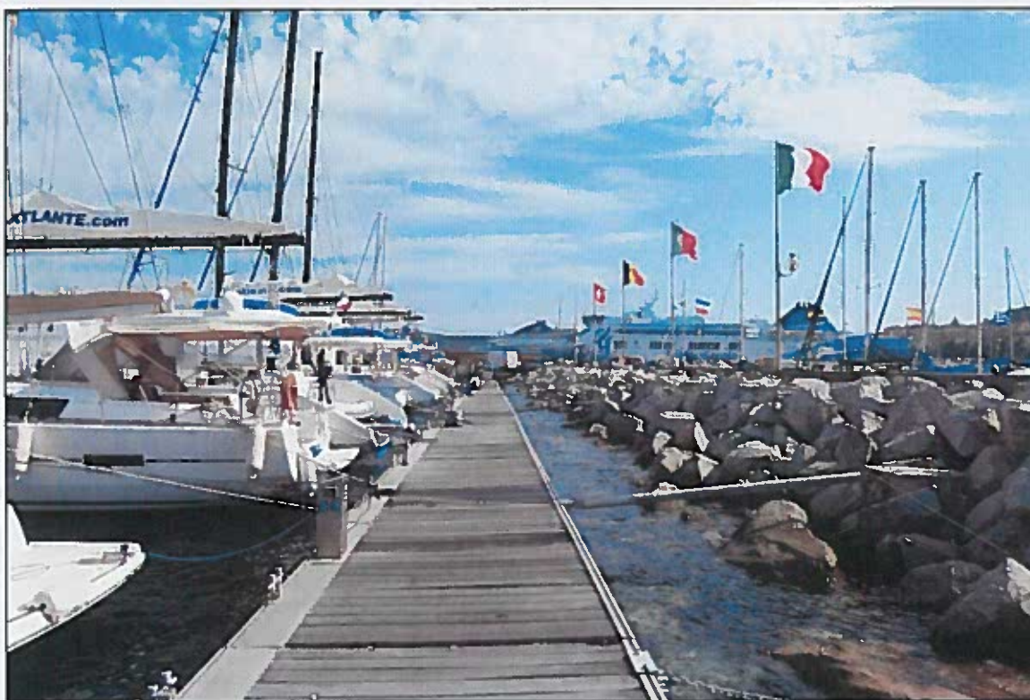
Vue d'installations portuaires similaires présentes sur le port Charles Ornano
