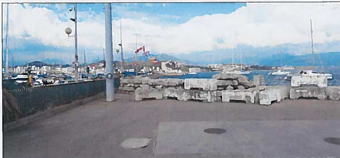
7 - Vue du stockage des blocs en béton (1 er juin 2017)
