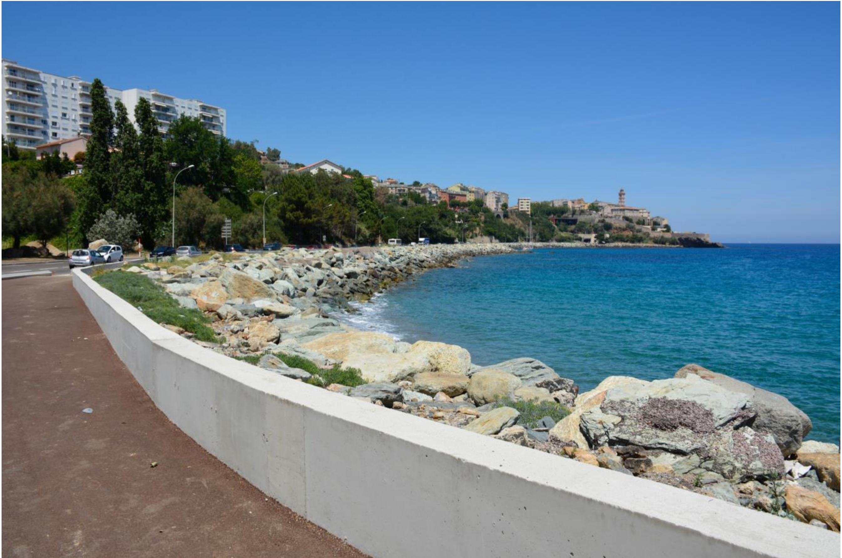
Vue actuelle – Route du front de mer
