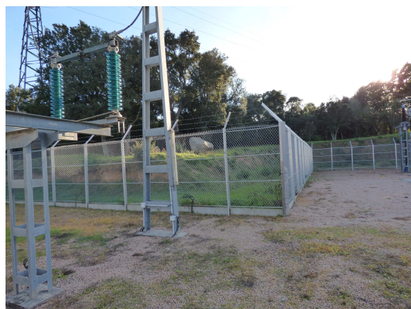
Vue d'ensemble de la partie extension
