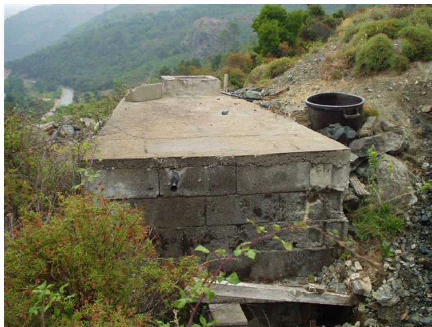
Vue de la bâche béton, hors service
