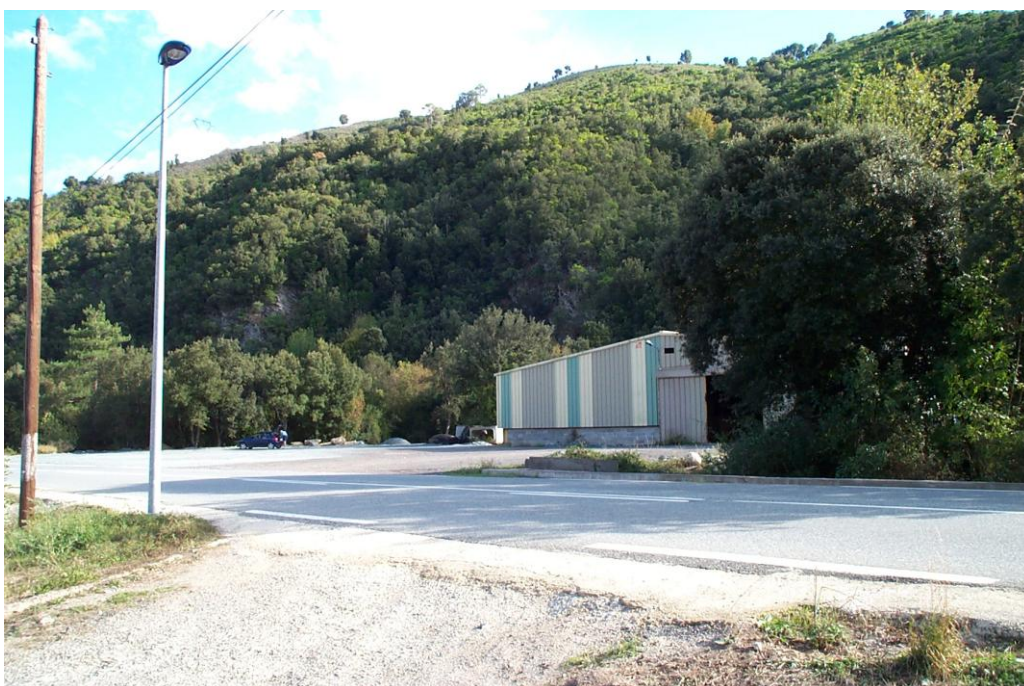
Garage situé au début du hameau de Campo Rosso (en direction de Bastia)
