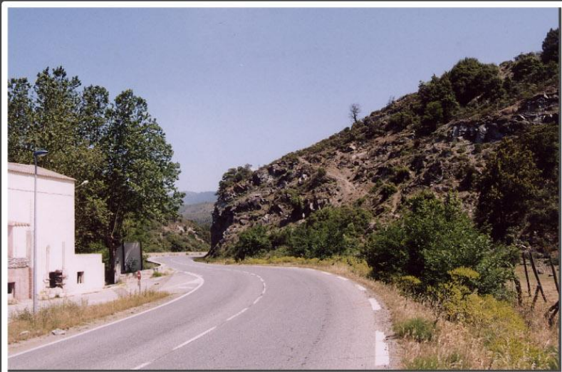
Virage à rectifier au sud du restaurant l'Escale
