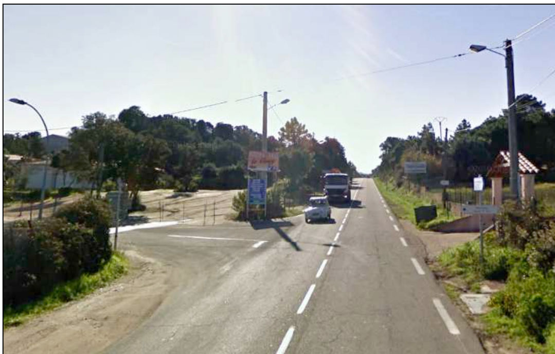
Carrefour RT10 / Route communale (Bocca dell'Oru) (en direction de Bonifacio)
