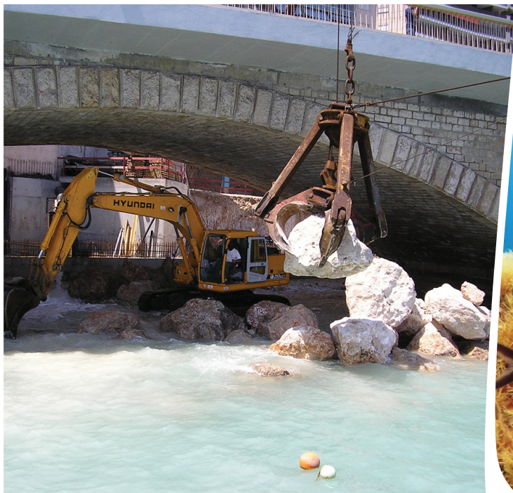
Travaux nécessitant potentiellement un dossier IOTA (©Egis)
