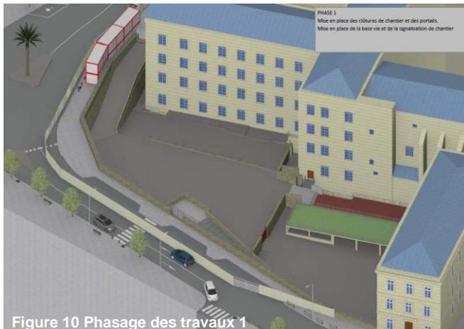
L'image de gauche montre une modélisation provisoire de l'installation de chantier. On remarque que la clôture de chantier est placée de sorte à ne pas contraindre le trafic, assuré par le maintien de deux voies de circulation.
