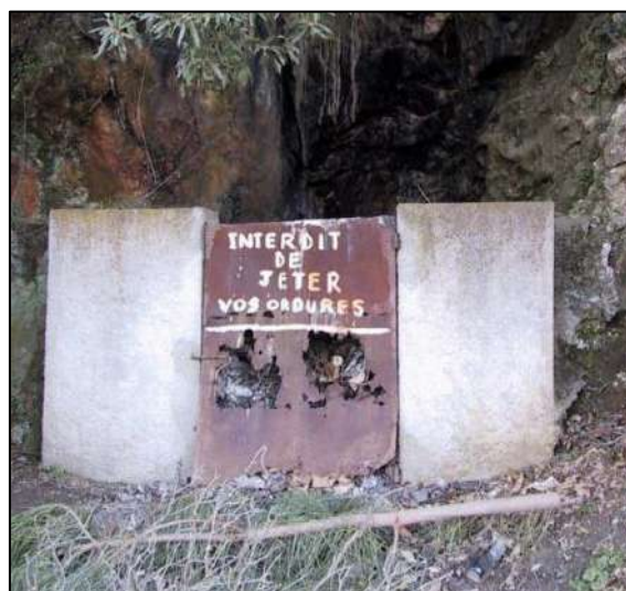
Figure 19 : Galerie G2 (ancien incinérateur communal) (2004)
