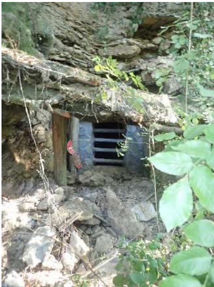
Galerie fermée à proximité du dépôt 2B_0024_A_T1
