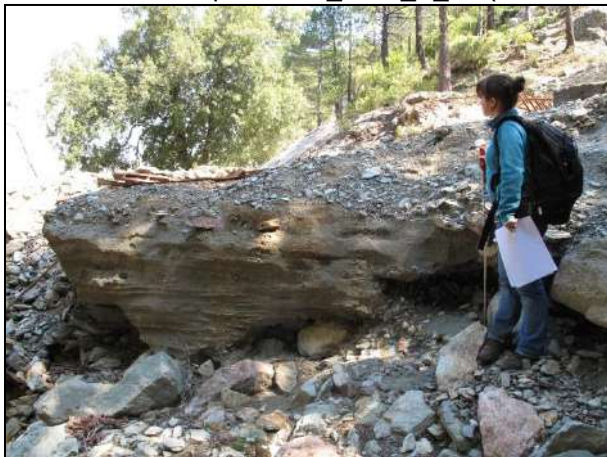
Dépôt de 2B_0003_A_T3 (résidus de traitement de la laverie récente)
