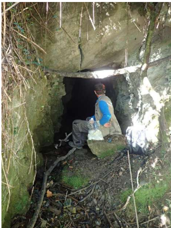
Ferralacce Galerie ouverte à proximité de la zone de dépôt de Feralacce (EAU-21-ERB-001)
