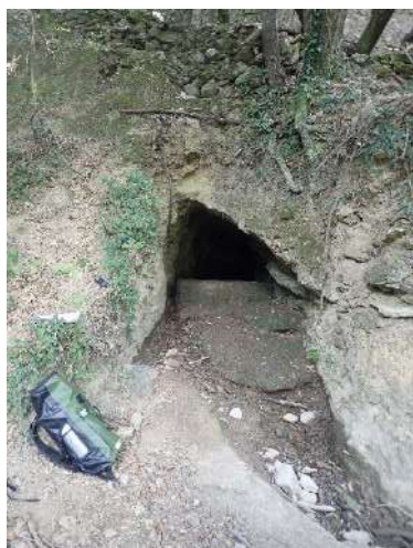
Galerie ouverte non connue en bordure du ruisseau Meria et en aval des travaux miniers (EAU-21-MER-01)
