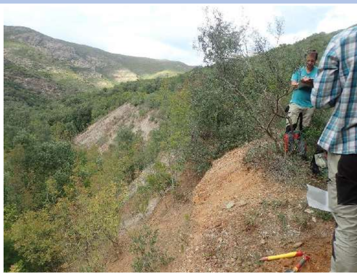
Dépôt 2B_0026_A_T1 avec des résidus de creusement orangés
