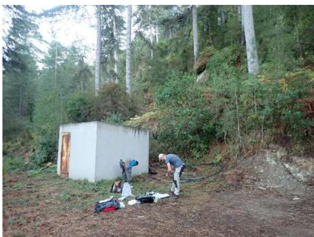
Puits de captage AEP pour l'eau du village de Rospigliani situé à proximité du col d'Erbajo (EAU-21-VEZ-005)
