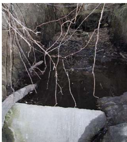
Retenue d'eau de la galerie G3
