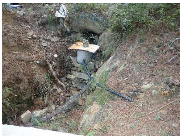
Poggiorello : Exhaure minière du niveau 00 à proximité du dépôt 2B_0010_A_T4 avec captage se dirigeant vers la partie aval du village de Vezzani (EAU-21-VEZ-002)
