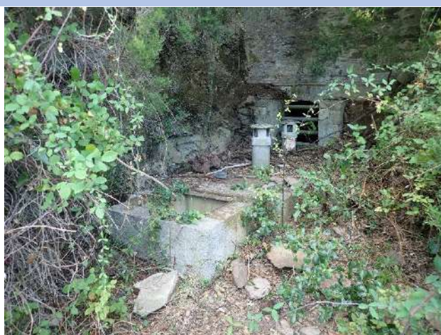
Galerie d'exhaure captée du TB de Guadiglio, à côté du dépôt 2B_0011_A_T1 (EAU-21-ERS-002)
