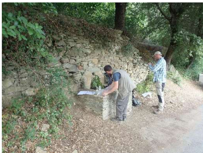
Fontaine en bordure de route à l'entrée du chemin qui mène aux dépôts (EAU-21-ERS-004)
