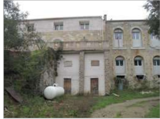
Vestiges réaménagés de la fonderie ; au centre de l'édifice, vue vers le Sud
