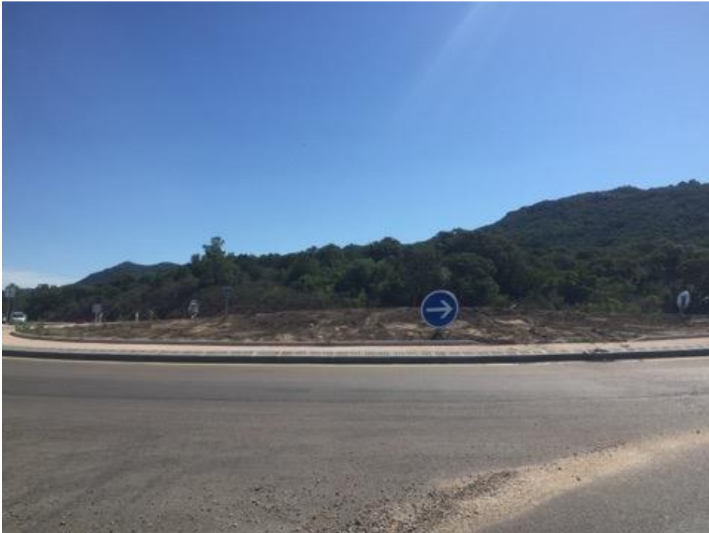
Rond-point amont terminé
