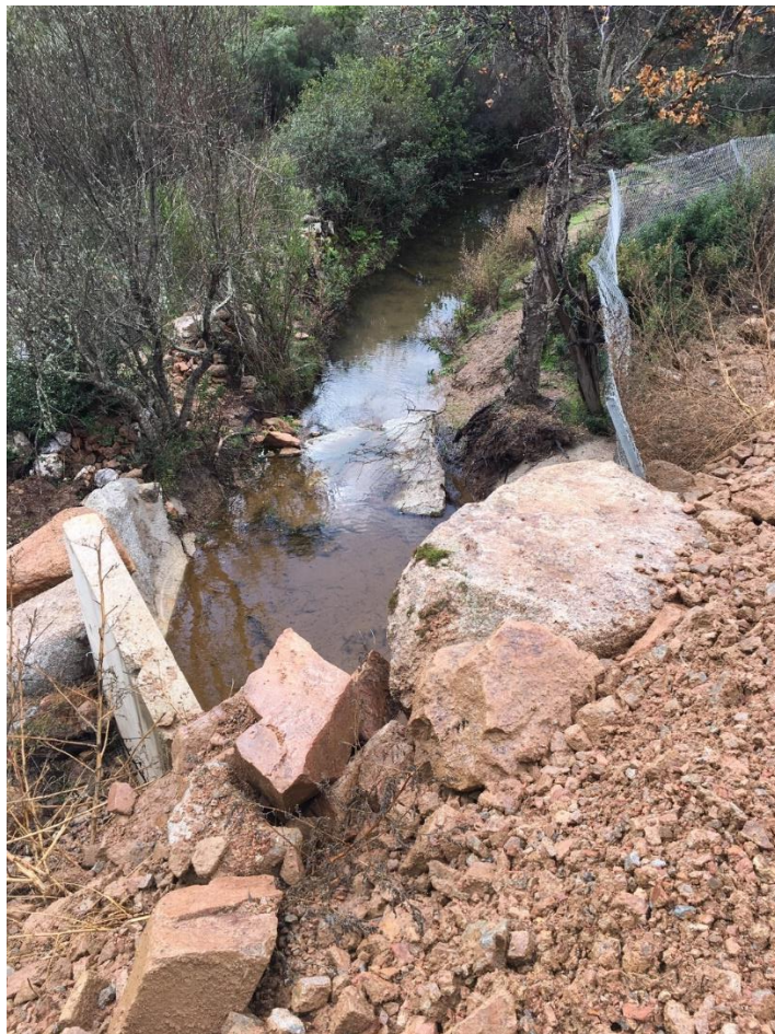
Ecoulement normal des eaux sous le dalot
