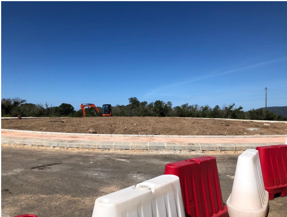
Rond-point aval terminé
