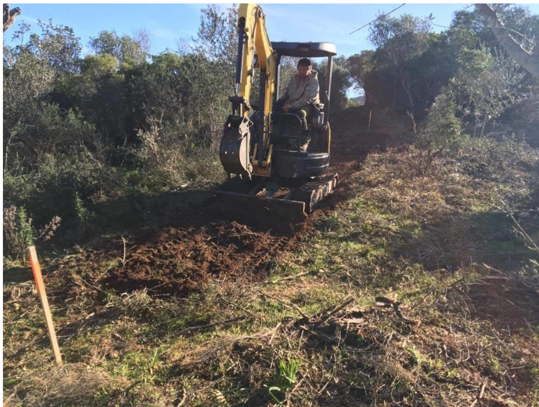
Photo 7 Création du layon pour installer la future clôture
