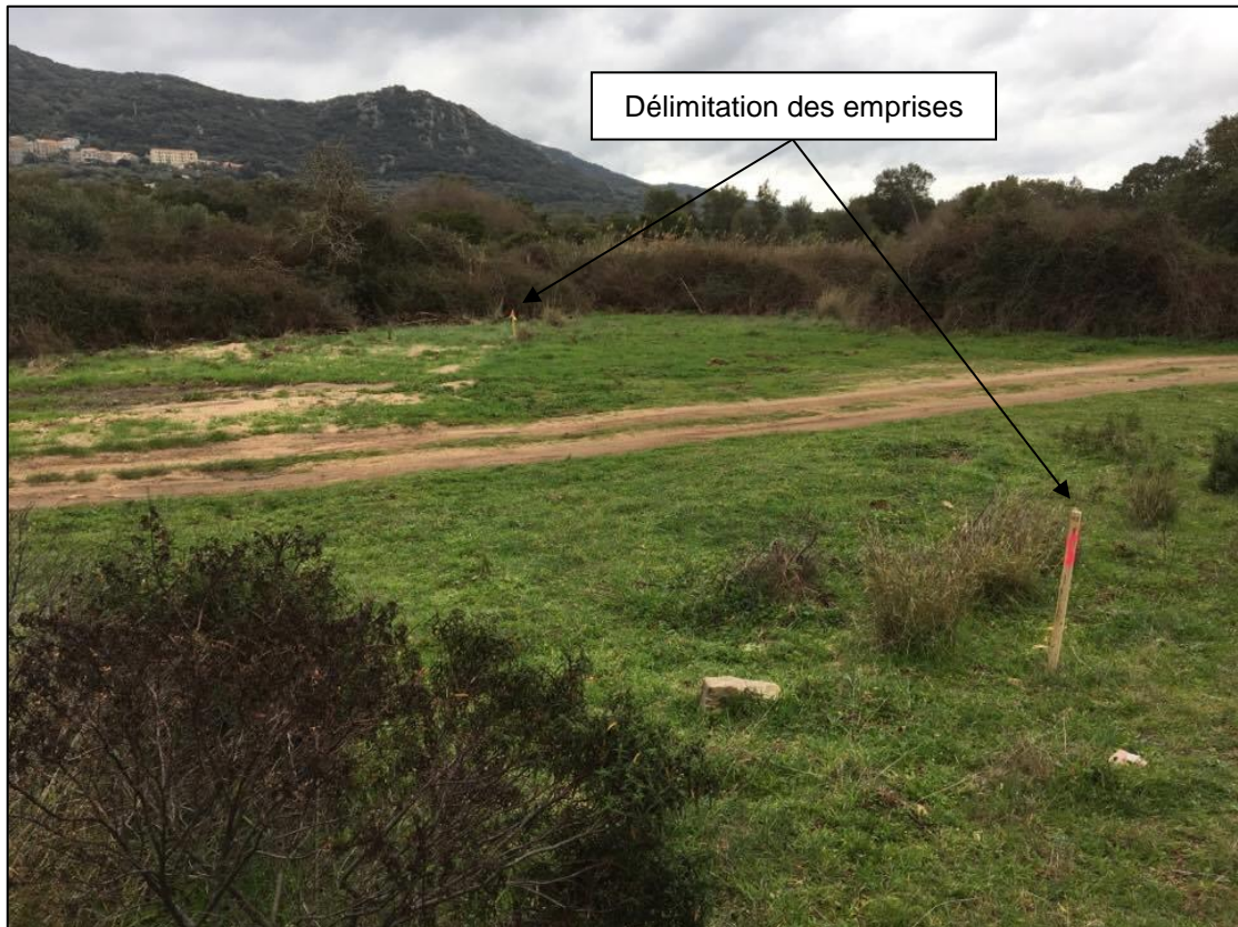
Photo 3 Vérification de l'implantation des emprises du chantier
