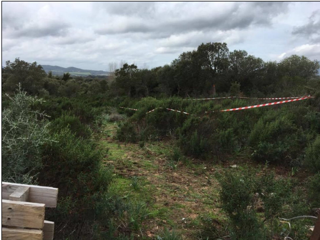
Photo 1 Emplacement de la zone de vie et de stationnement des véhicules du chantier
