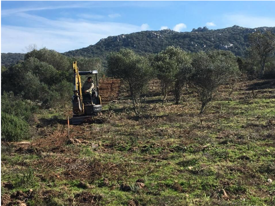
Photo 8 Création du layon pour installer la future clôture
