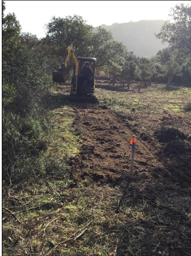
Photo 11 Création du layon pour installer la future clôture
