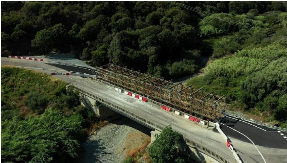
Figure 1. Vue du pont provisoire et du pont existant (source : Collectivité de Corse)
