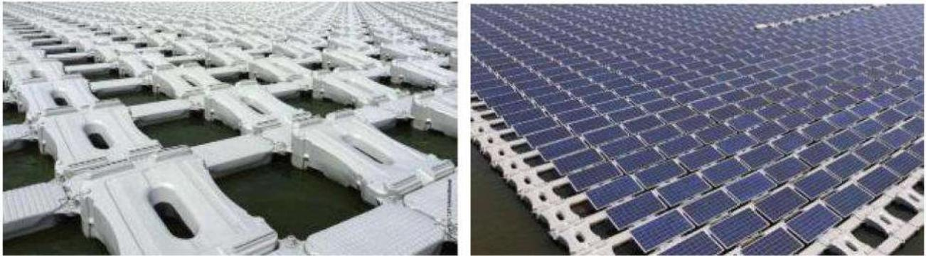
**Figure 6 : Assemblage des flotteurs et mise en place des panneaux solaires**
