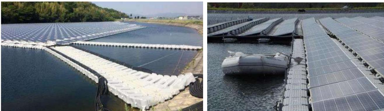
Figure 14 : Dispositifs types pour le contrôle des îlots flottants (passerelles et embarcations légères)
