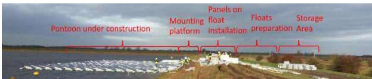
Figure 13 : Exemple d'une zone d'assemblage sur berge
