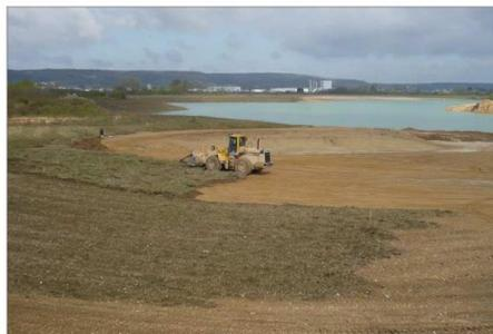
2. Reconstitution des pelouses sur la zone réceptacle : déplacement en vrac au premier plan ; déplacement par plaques au niveau de la chargeuse.
