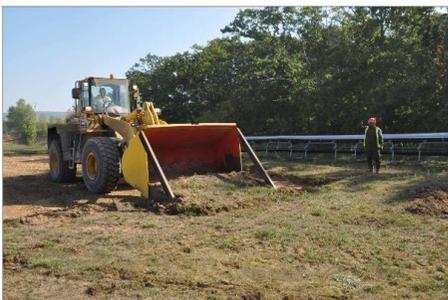
1. Prélèvement des plaques de pelouses sableuses sur le milieu d'origine pour être déplacées vers la zone réceptacle.
