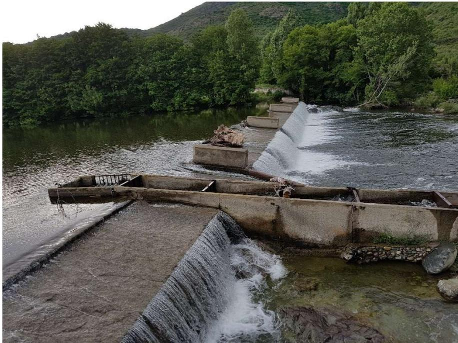
**Photographie 2 – Localisation clapet et passe à poissons**
