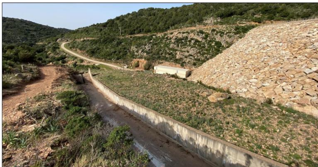
Photo 3. Photographie de l'évacuateur de crues du barrage de Figari (source : CETA)
