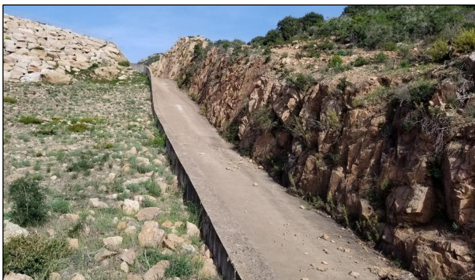
Réservoirs de stockage d'eau (Endemys, 2022)
