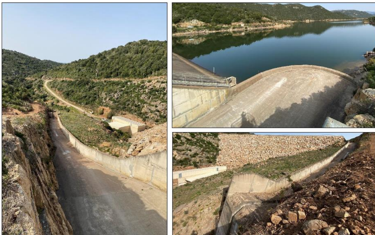
Photo 4. Evacuateur de crues du barrage de Figari
