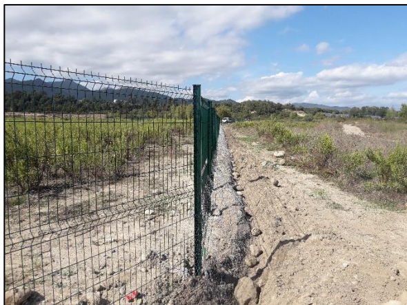
Pose en cours du dispositif complémentaire
