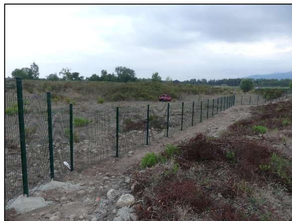
Dernier tronçon de grillage terminé avant la fin de la première session de capture
