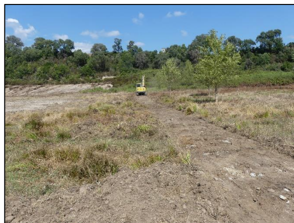
Intervention sur la partie nord
