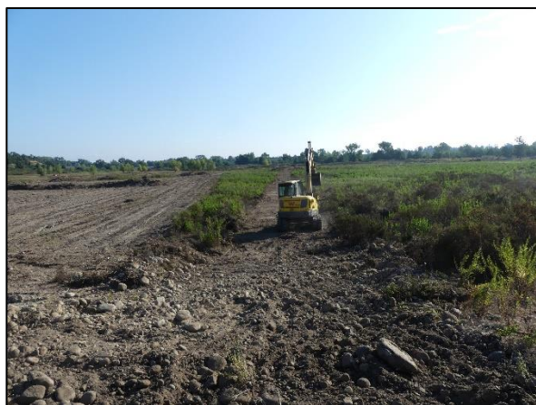
Intervention sur la partie sud
