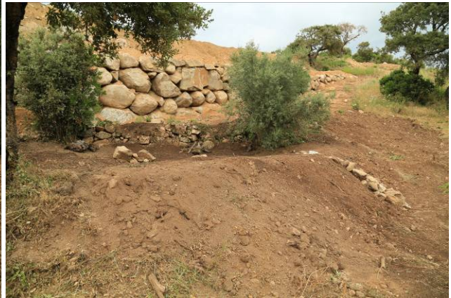
Aspect du merlon fini, raccordé au T.N.
