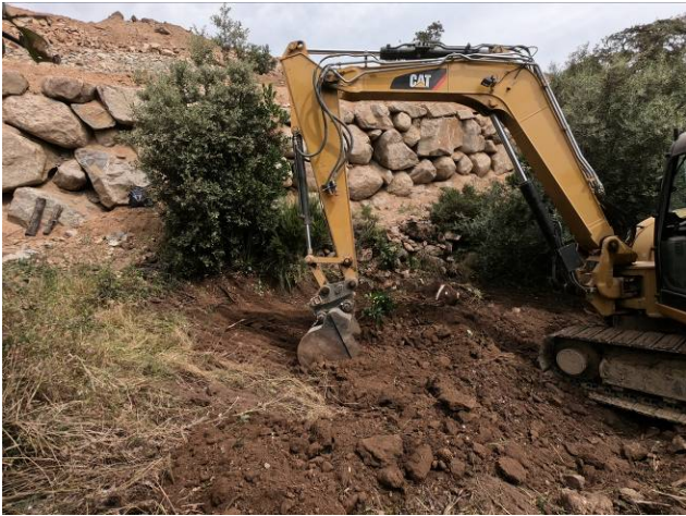
Terrassement de la mare à la pelle
