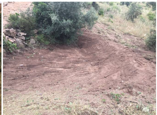
Couverture de la membrane de 30 à 40 cm de terre
