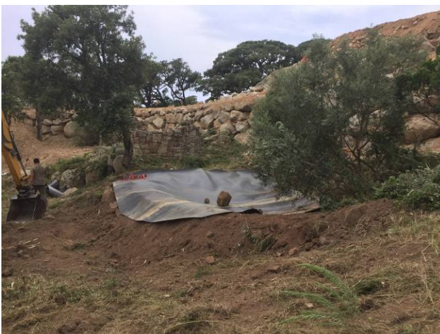
Pose de la membrane d'étanchéité
