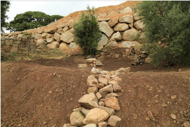
Aménagement du seuil déversant en enrochements
