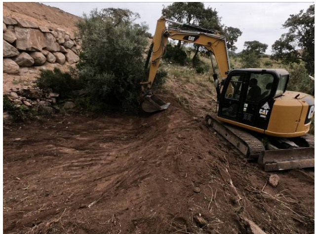
Création du merlon à l'aval
