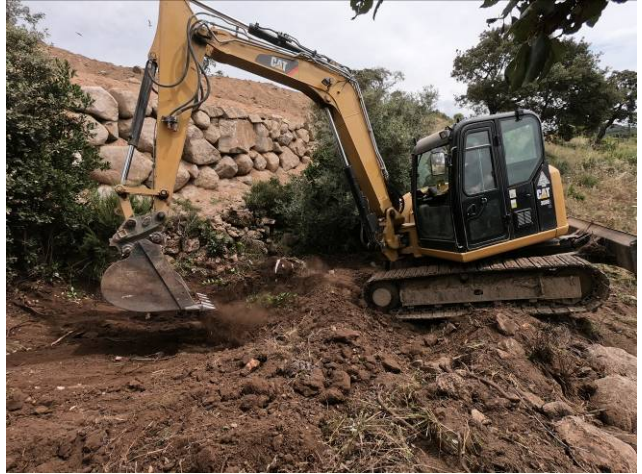
Surcreusement pour la pose de la membrane
