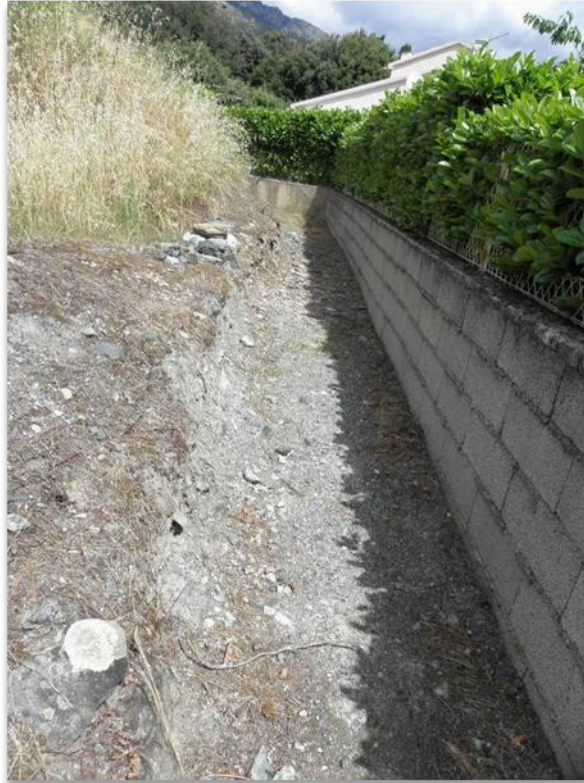
Illustration 11 : Petit talus creusé dans des serpentinites amiantifères, à proximité d'une propriété (quartier San Pancrazio, site 2BFC091).
