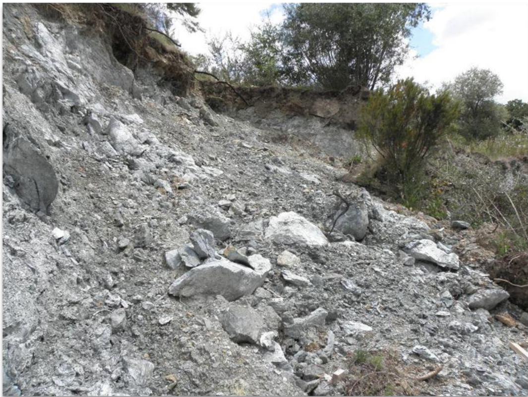
Illustration 22 : Talus du site 2BDL468, ouvert dans des serpentinites très altérées.
