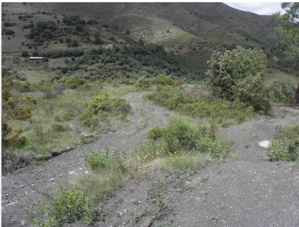
Illustration 19 : Vue générale du site 2BDL240, faiblement végétalisé et dégradé.
