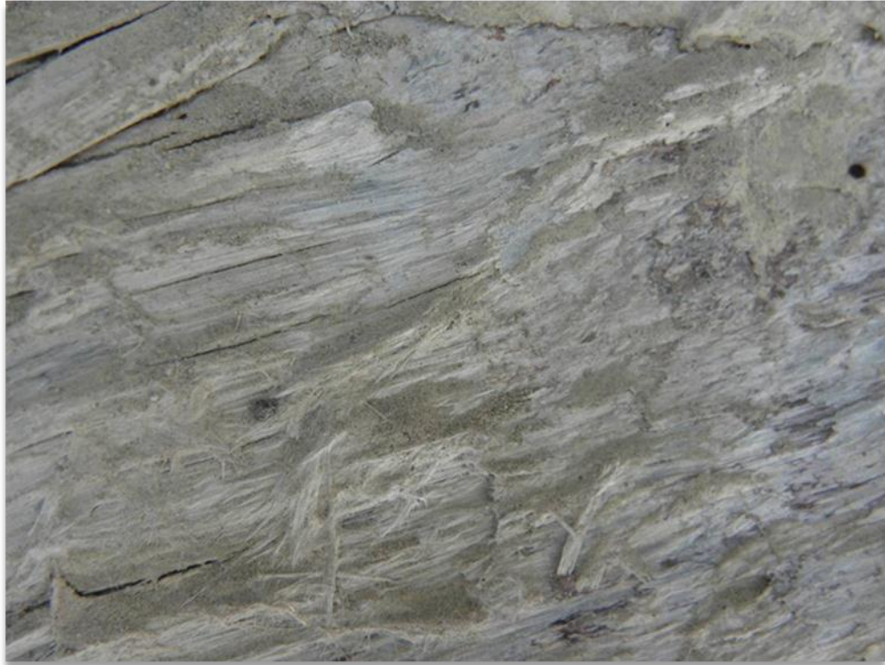
Illustration 32 : Détail d'un plan de glissement amiantifère affectant des métagabbros (site 2BFC100).
