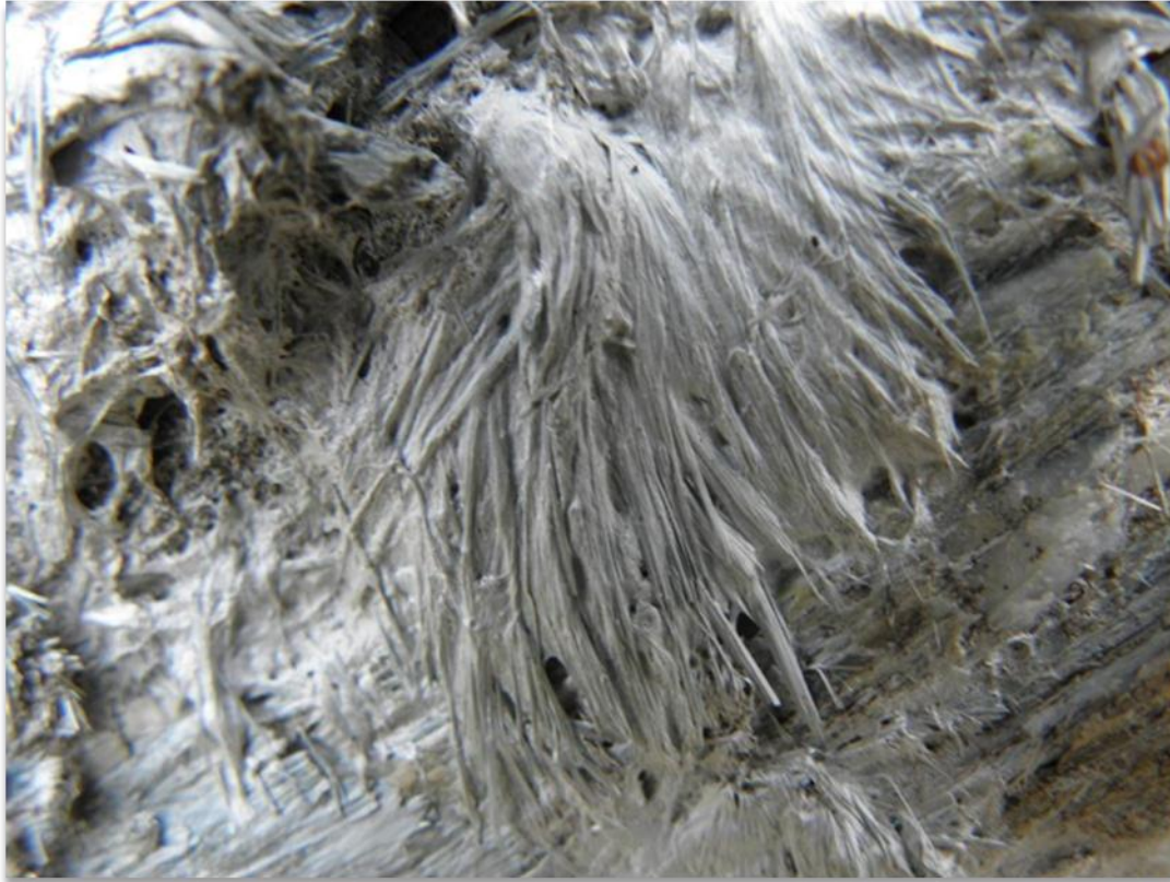
Illustration 38 : Vue détaillée des cristallisations asbestiformes reconnues sur le site 2BDL229.
