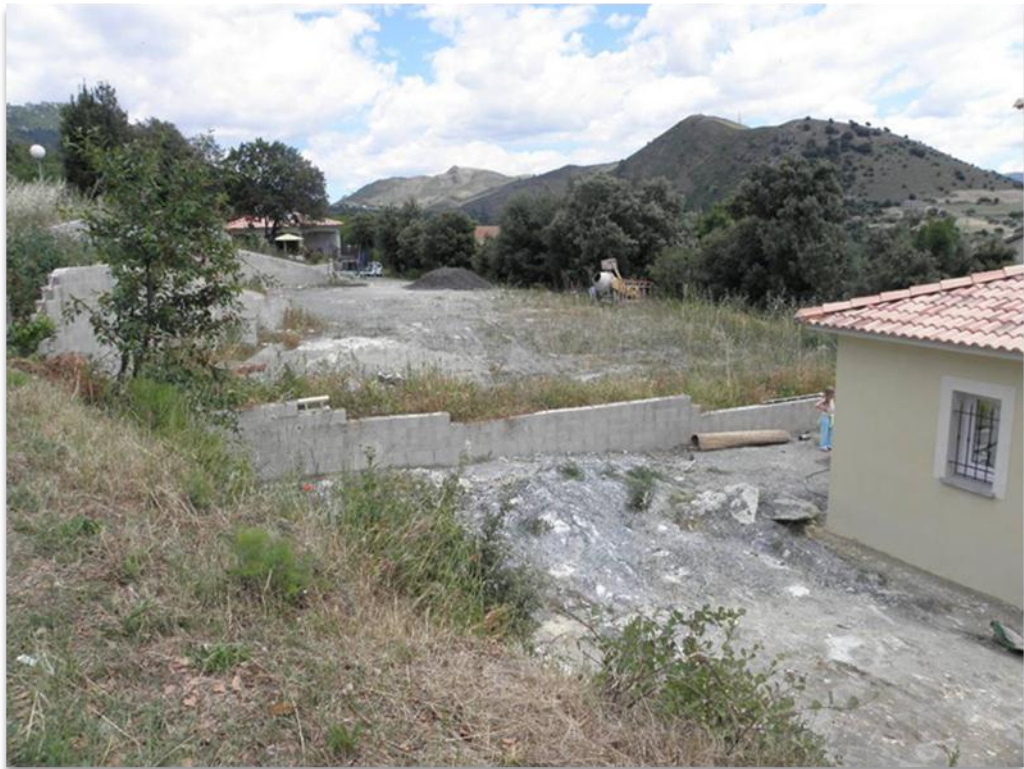
Illustration 14 : Déblais anthropiques de serpentinites amiantifères près d'une maison récemment construite (quartier San Pancrazio, site 2BFC096).
