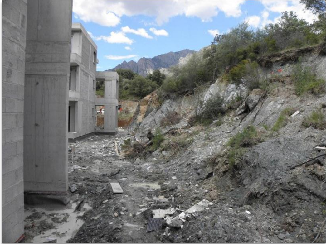
Illustration 21 : Vue du talus situé en arrière du chantier (site 2BDL468).
