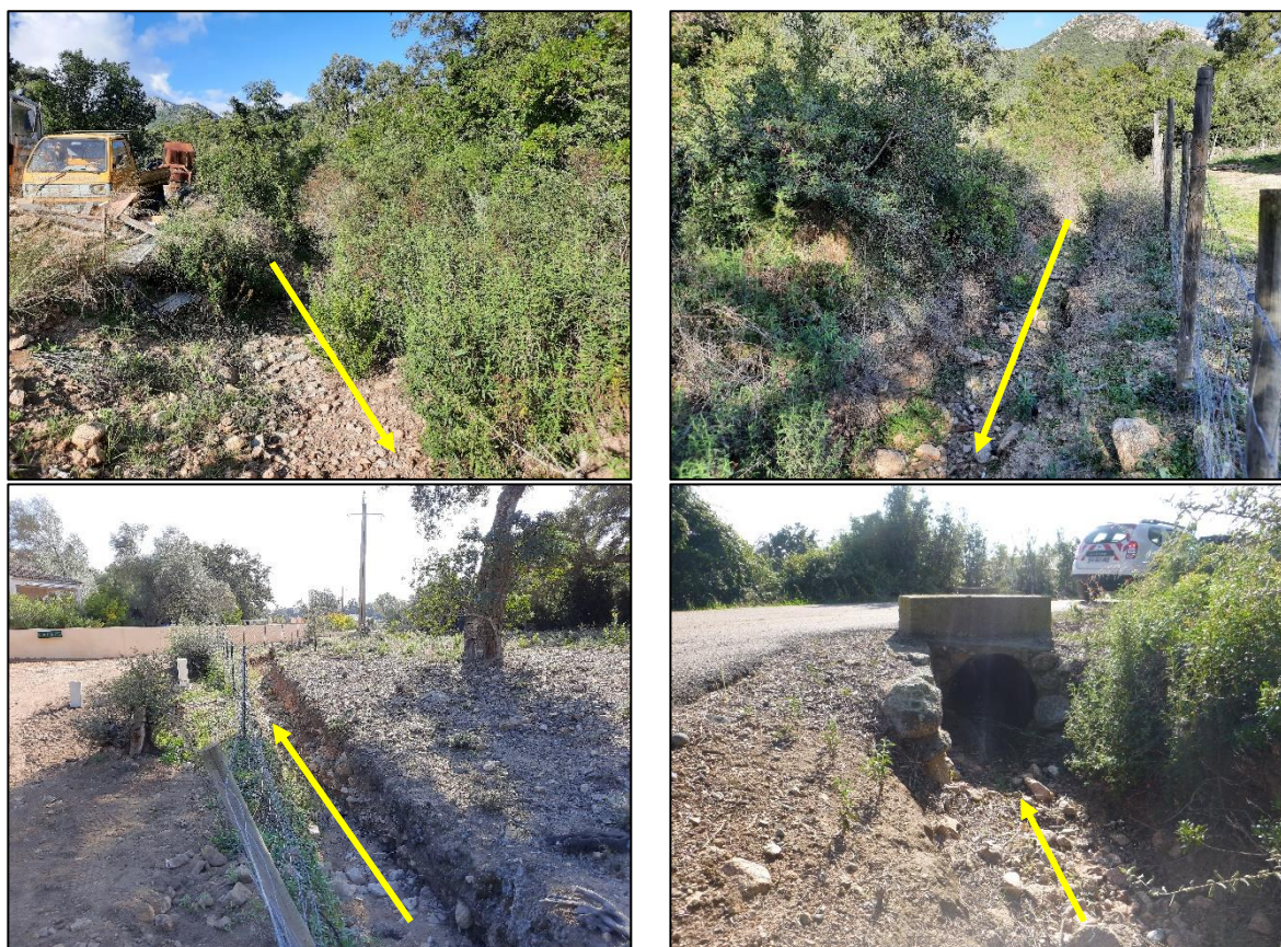
Photo 5 : Cours d'eau à sec à l'Est du projet et buse DN800 en traversée de voirie (13/11/2020)
