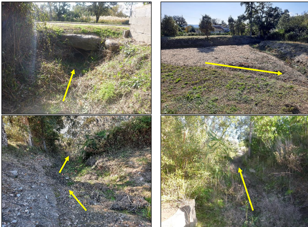
Photo 9 : Traversée de voirie, bassin privé et zone humide (13/11/2020)
