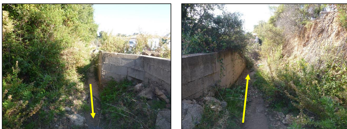
Photo 6 : Cours d'eau entre le talus routier et un mur (13/11/2020)
