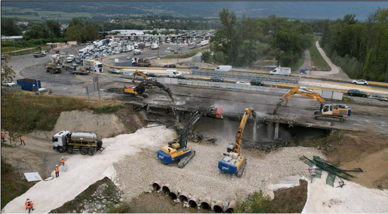
Figure 32 : Exemple de démolition par croquage et mise en place de plateforme busée - Echangeur de Chambéry A43/A41
