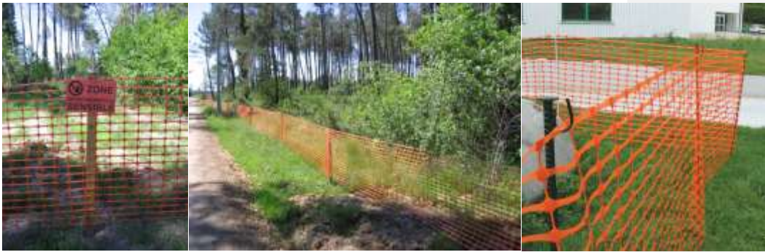
Exemples de balisage des zones sensibles et de bâche sur les grillages
