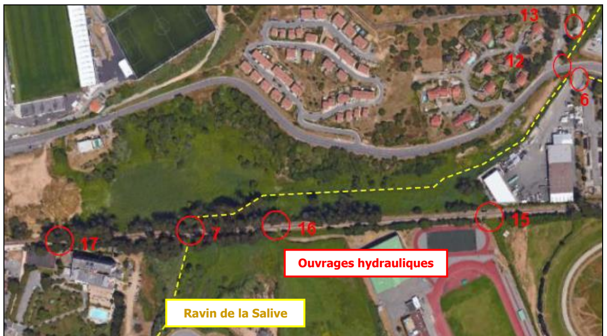
Figure 6 : Ouvrages hydrauliques aux abords du site (extrait : étude préliminaire d'aménagement hydraulique de la zone du Vazzio – ARTELIA)
