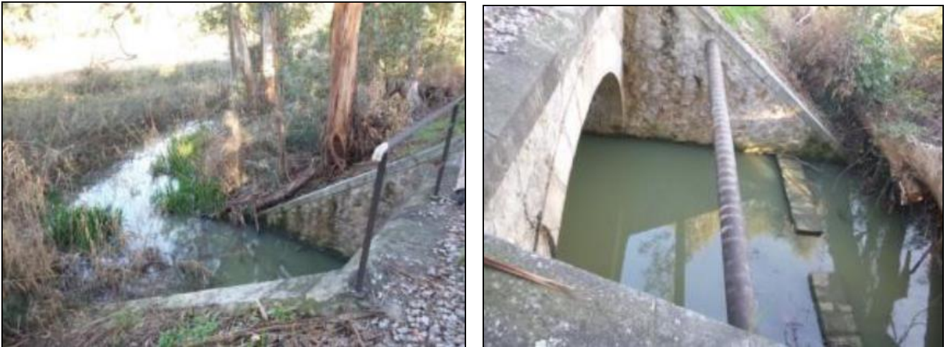
Figure 4 : Vue de l'ouvrage hydraulique 7 (extrait : étude préliminaire d'aménagement hydraulique de la zone du Vazzio – ARTELIA)
