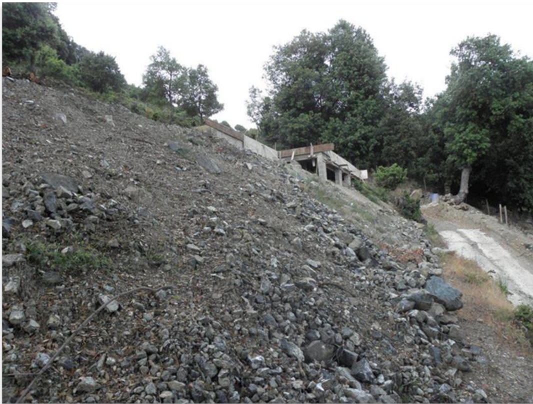
Illustration 18 : Déblais riches en amiante associés à un chantier de construction (2BDL295).
