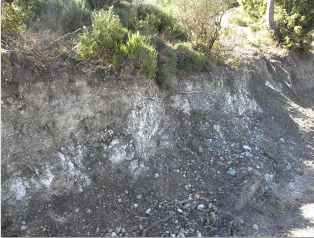
Illustration 27 : Chemin ouvert dans des serpentinites, avec mise à nu d'amiante (2BFC038).
