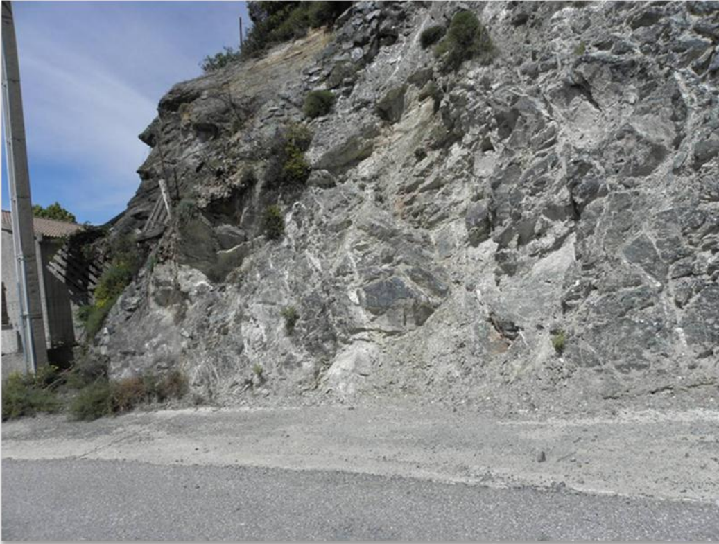
Illustration 13 : Talus routier très riche en structures amiantifères, situé près d'une habitation (site 2BFC056).
