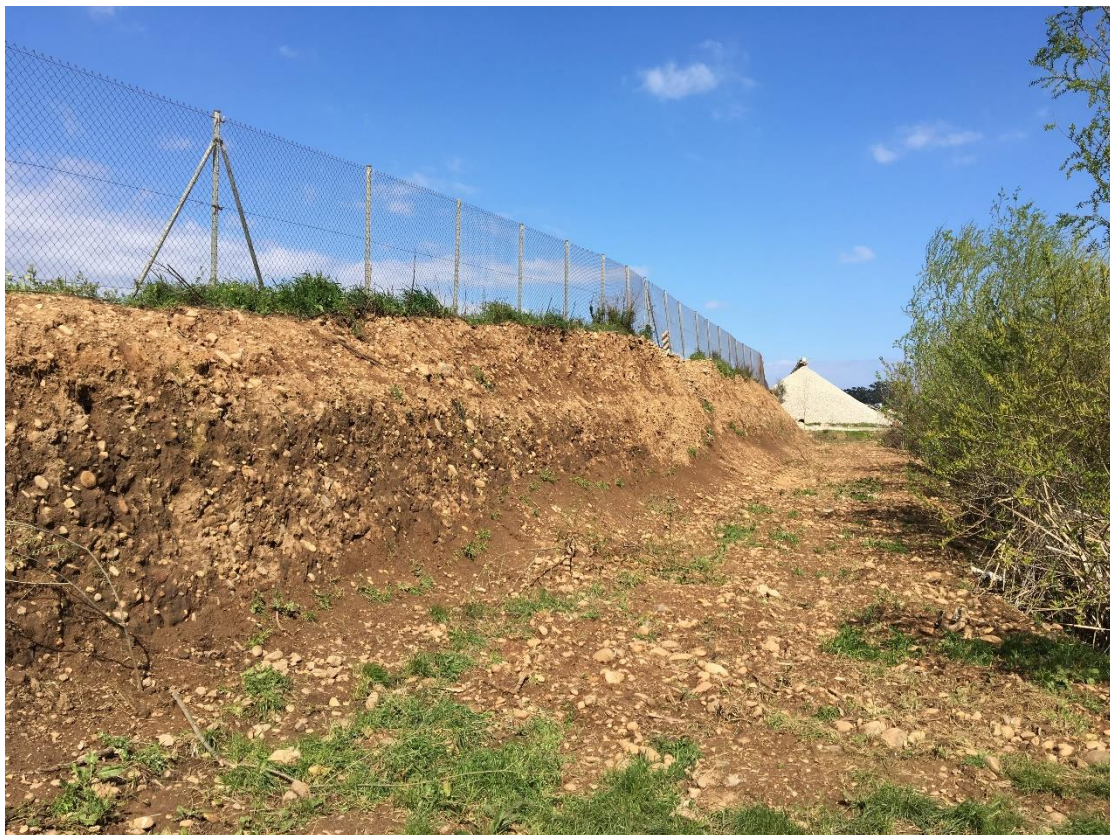
Photo 1. Talus nettoyé avec enlèvement des végétaux (22/03/2018)
