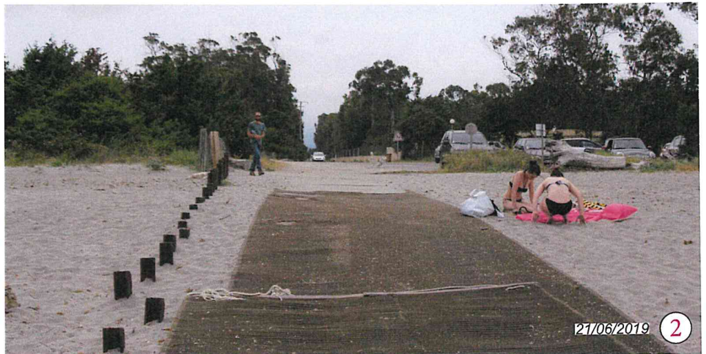
La mise à l'eau et son système de tapis métallique amovible Les pieux métalliques de bouclage des véhicules seront renouvelés
