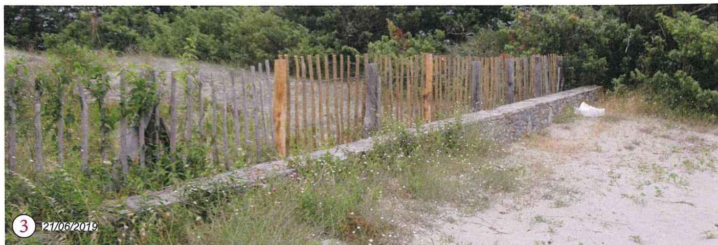
Le muret bas est doublé d'une ganivelle abimée par endroit, ce qui peut laisser le passage aux motos.
