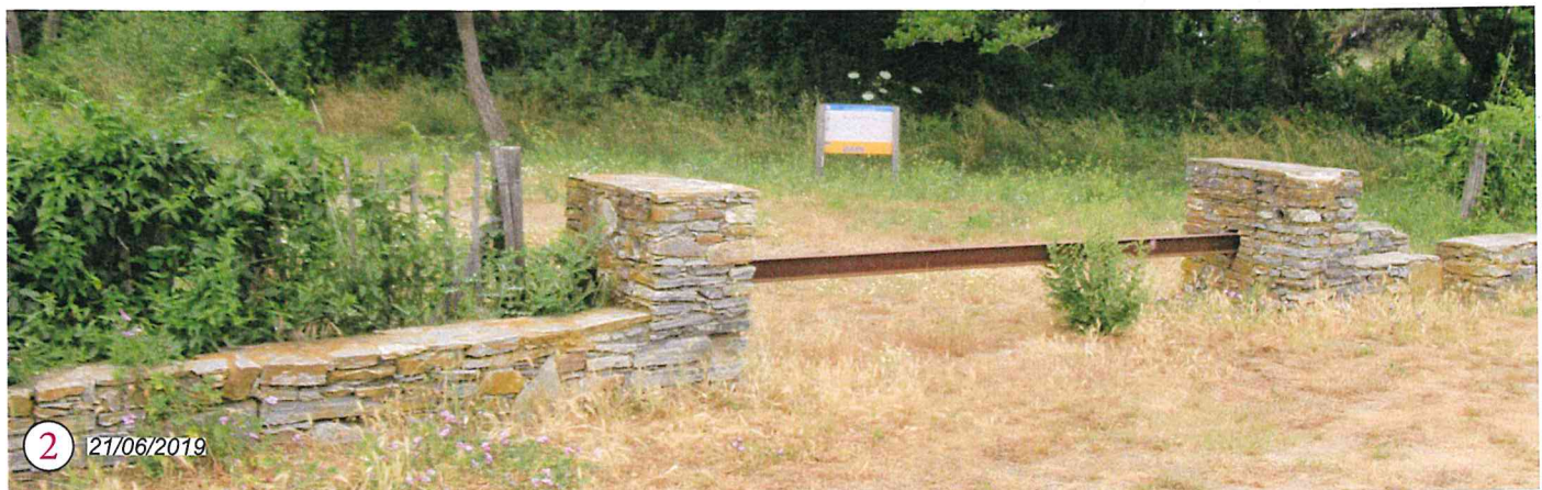
Un muret bas empêche l'accès des véhicules à la zone naturelle, et une barrière simple composée d'un IPN amovible permet un accès technique pour les gestionnaires.
