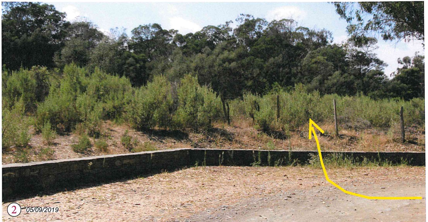
Le muret existant sera supprimé et un passage sera ouvert dans le talus pour laisser passer la nouvelle piste d'accès.
