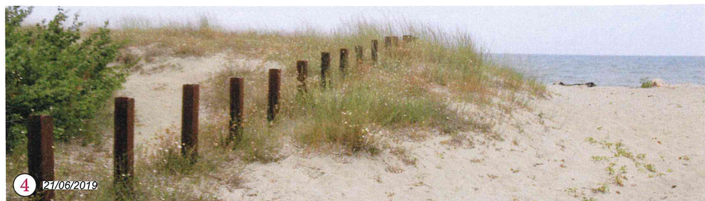
Des rails de chemin de fer assurent un blocage des véhicules à la plage, un dispositif déjà ancien qui a fait ses preuves.
