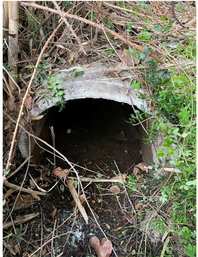
Lors de notre passage caméra (Vidéo tronçons 4 dans le dossier) nous constatons un dépôt vaseux sur le fond de notre réseau pluvial mais rien n'empêchant l'évacuation correcte des eaux pluviales à l'intérieur de notre canalisation.
