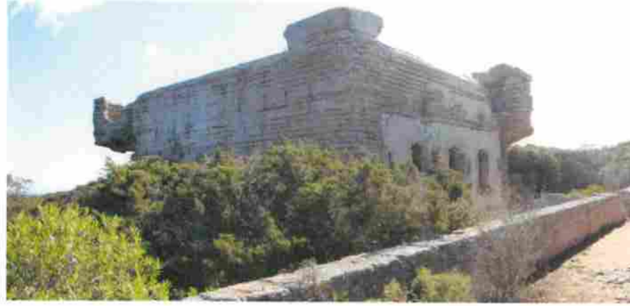
2 - Façade ouest, coté sentier, le bâti n'est plus accessible, le pont n'existe plus.
