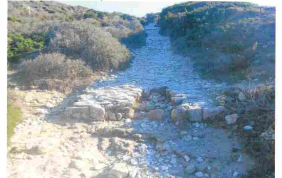
8 - Ancienne calade à restaurer ponctuellement.
