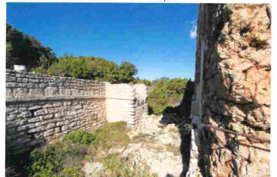
9 - Détail du muret parapet coté aval, surmontant le mur de soutènement.
