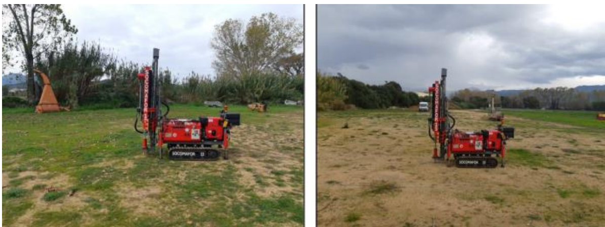
Photos n°3 et n°4 – Vue avec implantation des sondages de l'étude géotechniques
