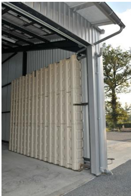
Exemple 9 Réservoirs de 500l
