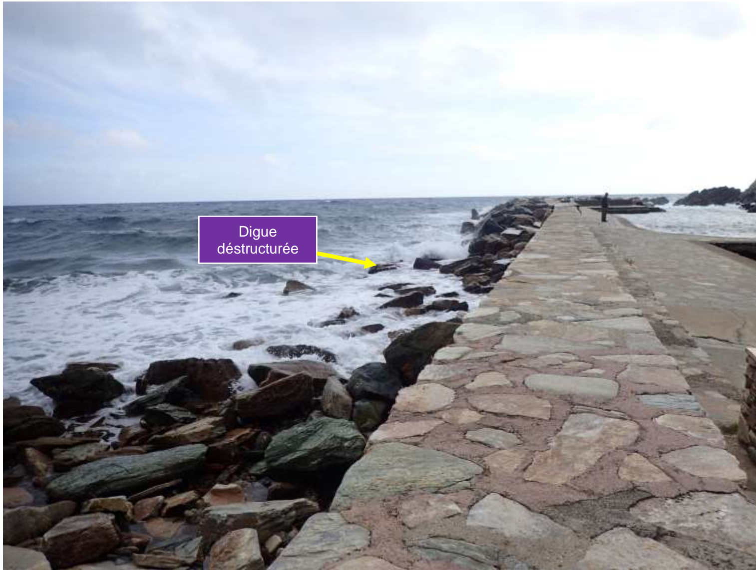
Figure 3. Photo 1, digue en enrochement du port d'Erbalunga, déstructurée – ICTP Octobre 2020
